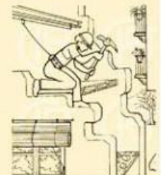
OPERARIO CON CINTURÓN DE SEGURIDAD
